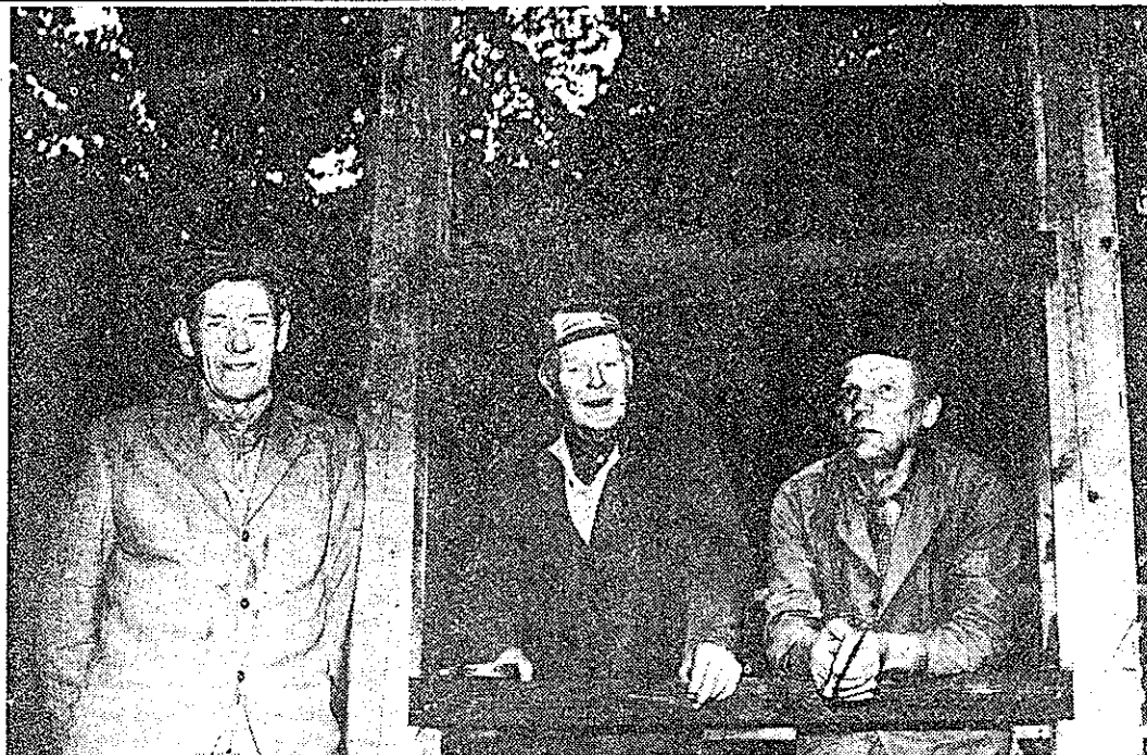
Lagom till 50-årsjubileet håller Ekeby hembygdsförening på att uppföra ett magasin för förvaring av större museiföremål. Bertil Johansson (t v), Gustav Bengtsson och Sven Johansson är sysselsatta med bygget
