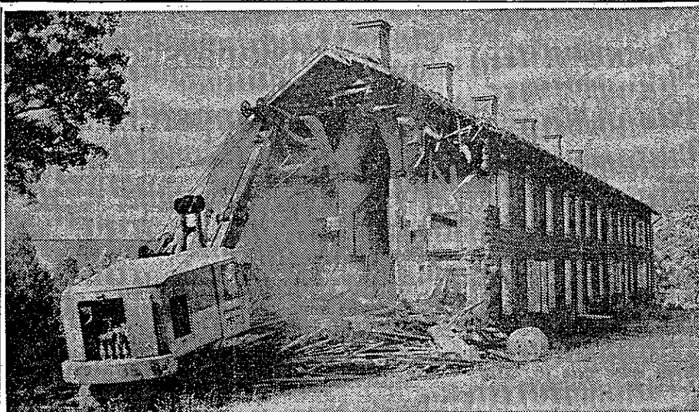
Grävskopan ses här äta sig in i Långholmens trävirke
