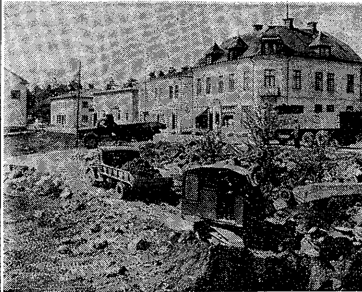
Grävmaskinen i arbete. Till höger resterna av den gamla stengårdsgården, som nu försvinner
