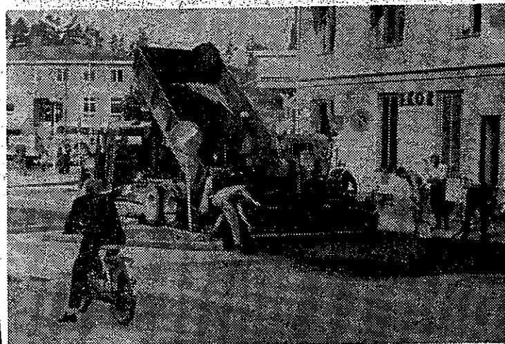
Asfaltbeläggningen på gatorna pågår
