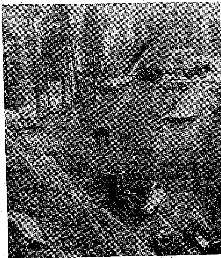
Arbetet pågår med djupdike vid Boxholms kyrkogård
