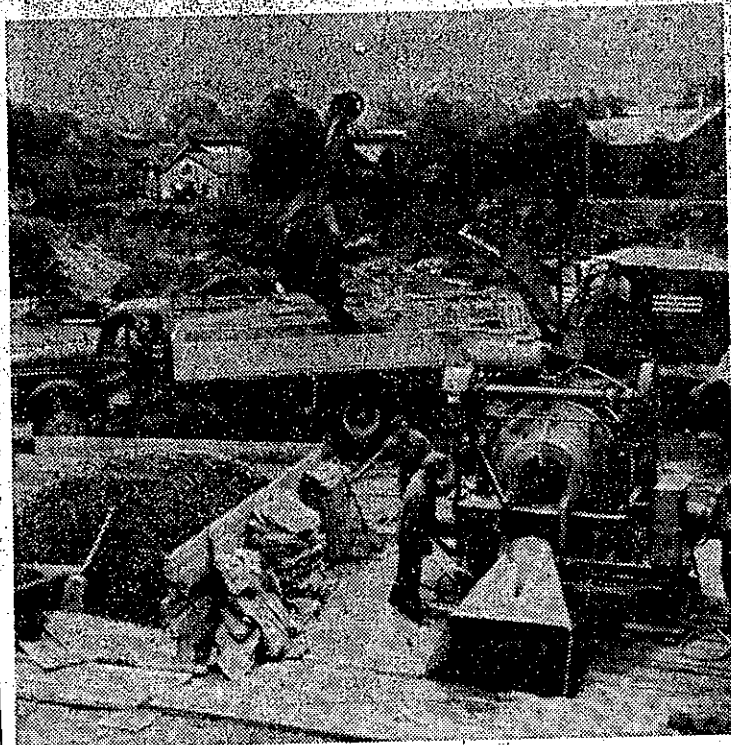
Det råder febril verksamhet på arbetsplatsen
