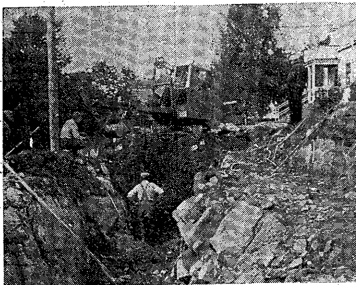
En bild från ledningsarbetena.
