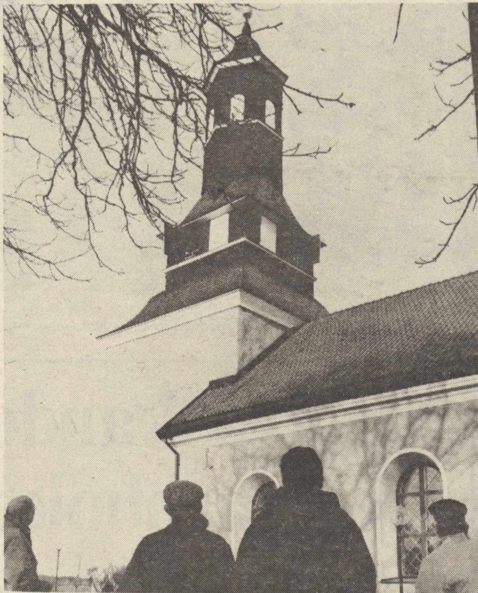
Inspektionsgruppen fick sig en ringning av den nya elektriska automatringningen.
