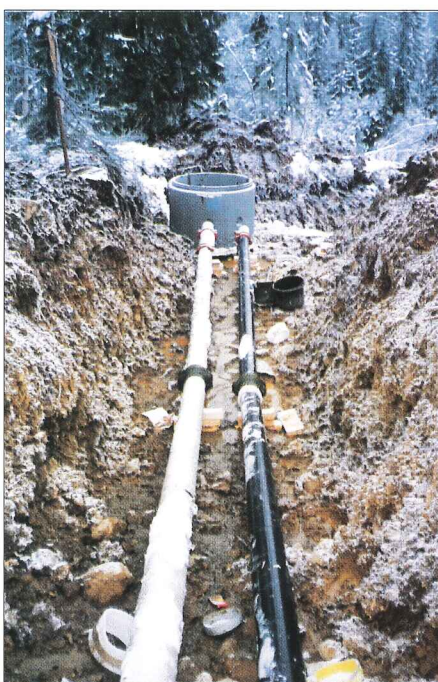
Prototypinstallationen vid snowboardbacken i Trysil. Det svarta röret till höger är det nya systemet.
