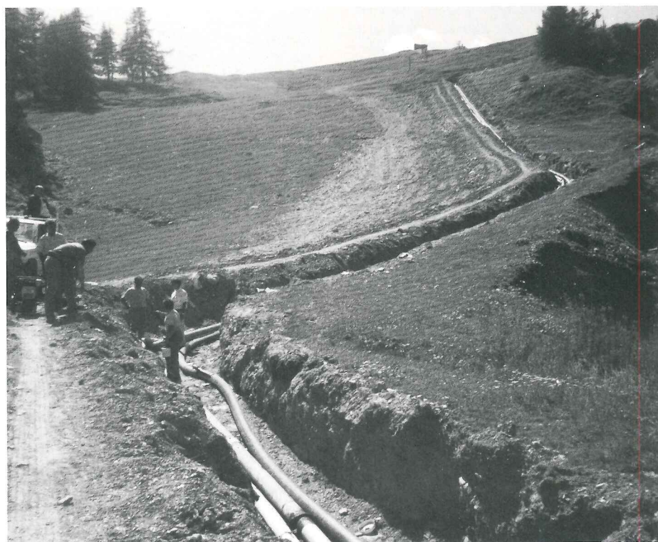
Öppna rörgravar inspekteras.
