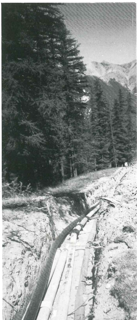
Alveniusrör på plats, Les Hautes Alpes skymtar i bakgrunden.
