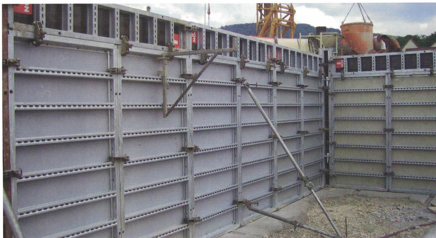
Formworks, de gråa plattorna är Sonoboard
