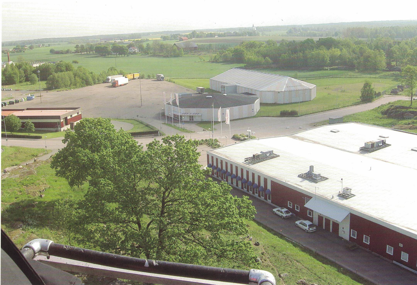
Fastigheten i Ödeshög
