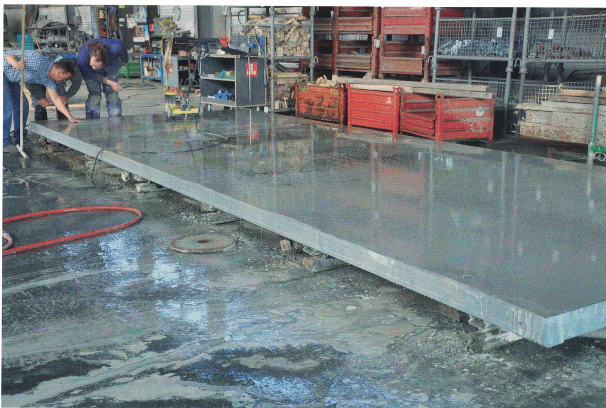
Sonoboard som formbyggnadsyta är i stort opåverkad efter 220 ggr användning. Plywood hade fått bytas ut efter 40-50 ggr enligt Jan Thomassen.
