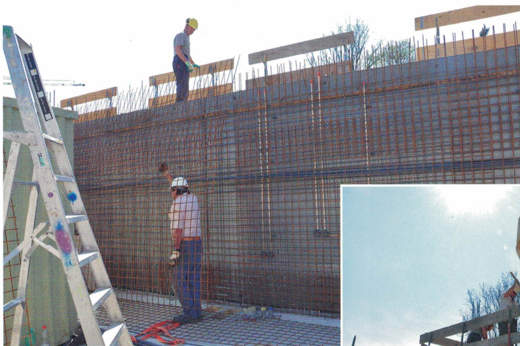
Sonoboard monterat i en 9,5 meter lång formram. Bilden visar infästning av tomrör och kabeldosor för el. Mitt i bilden går ett horisontellt vattenrör som skall gjutas in. Arbete pågår att tillföra den armering som skall vara i den blivande väggen.
