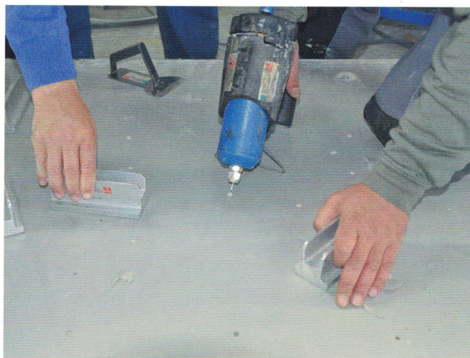
De hål eller gropar som blivit i plattorna efter montage av el- och vattenarmaturer fräses upp och lagas med smält termoplast.
