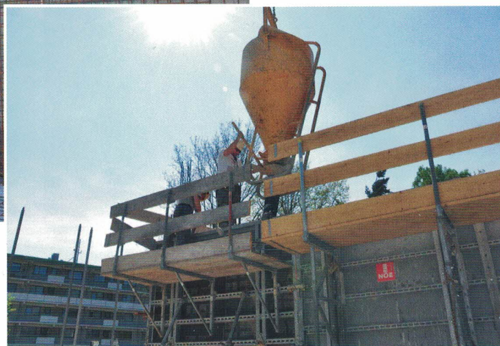
Efter att den andra formhalvan monterats med distanser och form-utrymmet tätats av är det dags för betong-fyllnad.
