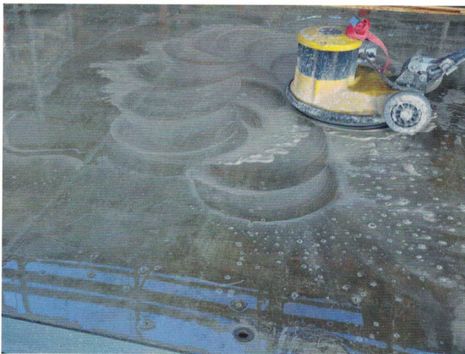
Rengöring av Sonoboard med Schwamborn-maskin.
