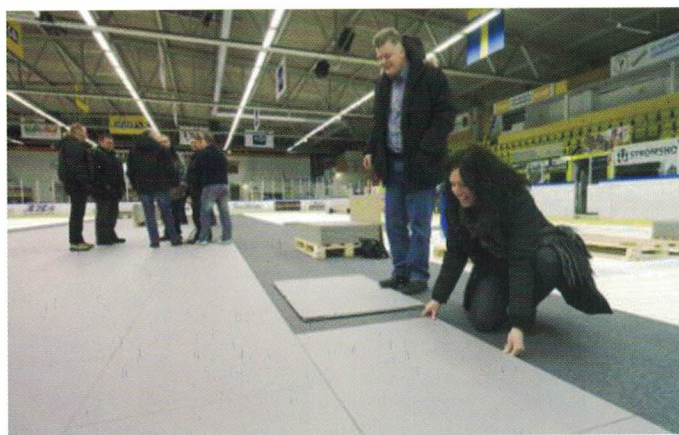
Petra, Hallchef Sparbanken Lidköping Arena, tyckte golvet var lättlagt.
