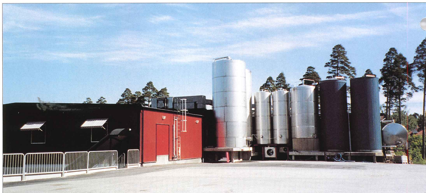
Nu är anläggningen i stort sett klar.
