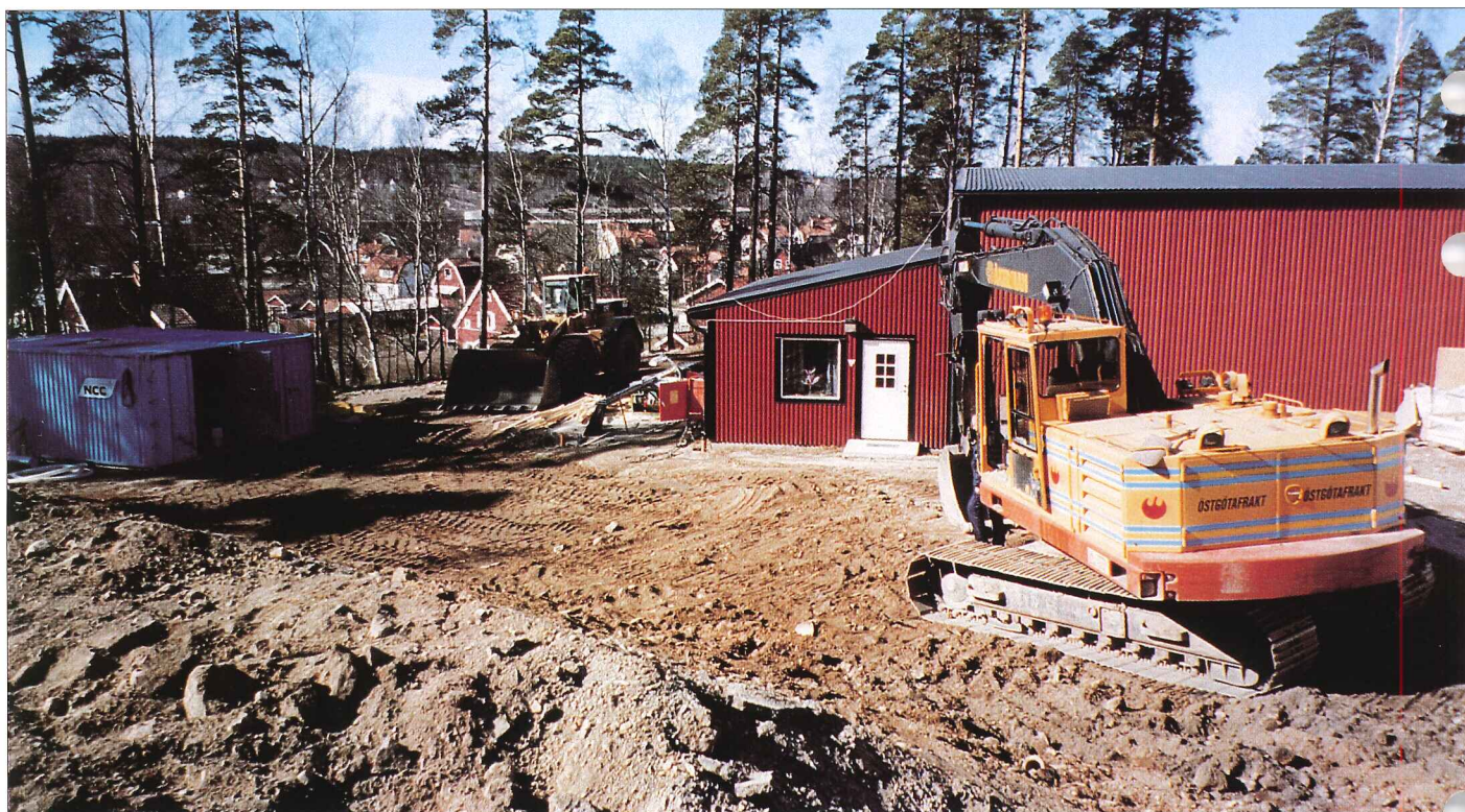
Så här såg det ut när arbetet med utbyggnaden påbörjades.
