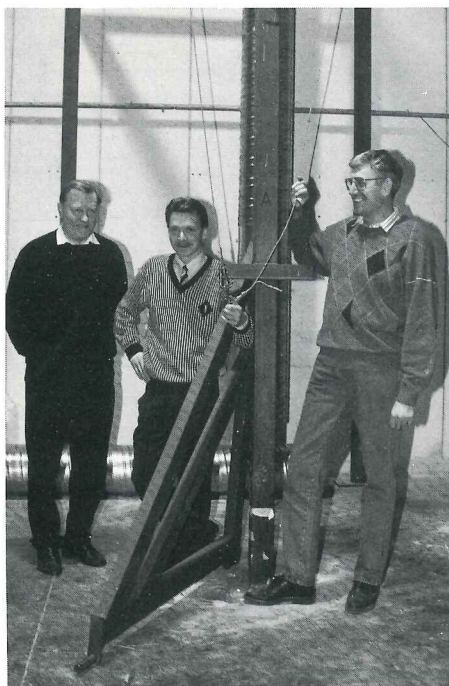
Den första kranen med telferutrustning kommer på plats. Gösta Kindström är mycket nöjd efter att ha konstaterat att mått och placering stämmer enligt ritningar.
