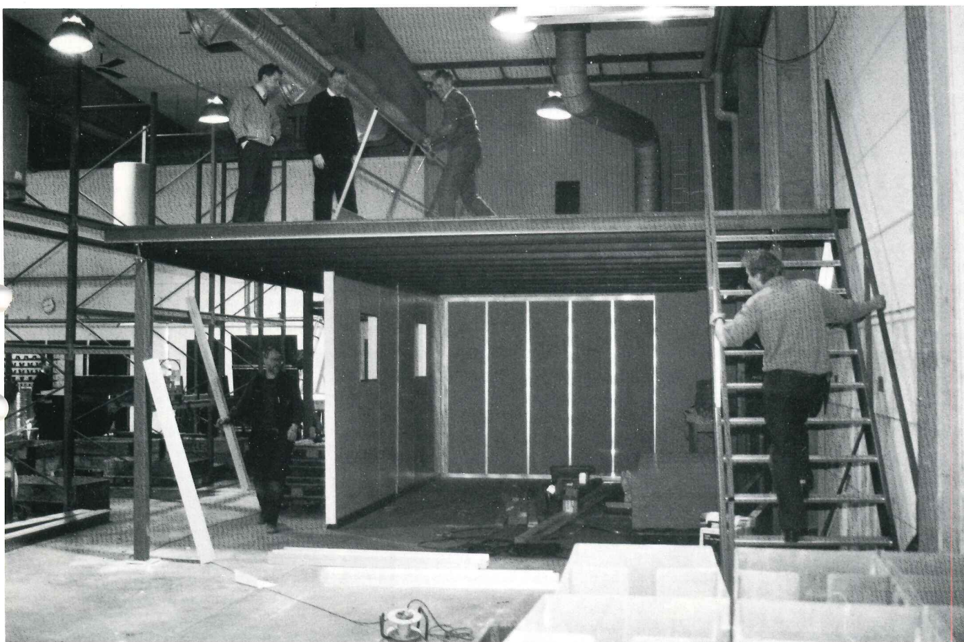
Entresolplanet är på plats. Under entresolet kommer ett efterbearbetningsrum och ett blandningsrum att iordningställas. Mårten, Erik och Gösta inspekterar.
