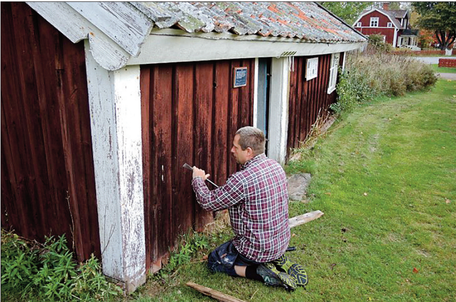
Entreprenören Marcus Samuelsson har här påbörjat borttagning av ytterpanel för att kontrollera konditionen på virket innanför. Bild: BO GARPEVIK
