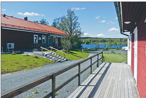
Till vänster ses Målsånns nyaste byggnad innehållande reception och café, och närmast i högerkanten ses servicehuset, en byggnad med kök, toaletter och dusch.
