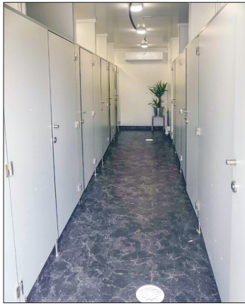
Servicehuset har en korridor och separata bås med toaletter till vänster och duschbås till höger.
