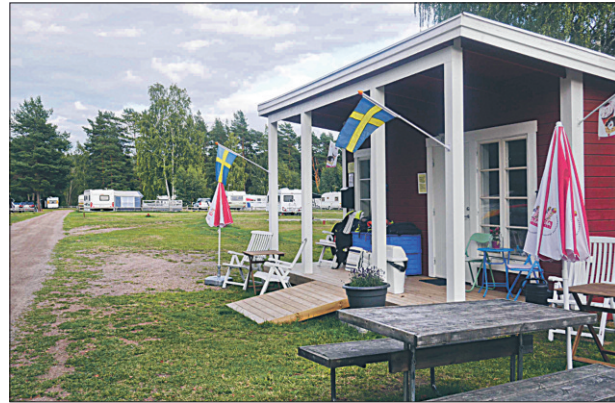
Till denna säsong stod en ny receptionsbyggnad klar vid campingens infart. Bygglovets är tillfälligt och byggnaden kan flyttas om det skulle behövas. Ingen vet ju än vad den blivande detaljplanen över området kommer att visa.
