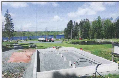
Ett nytt servicehus till campingen samt en stuga med bastu, har precis börjat byggas. Det ska tas i bruk till nästa års säsong. Fram till dess finns en barack med toaletter och dusch och den fungerar bra den också.
